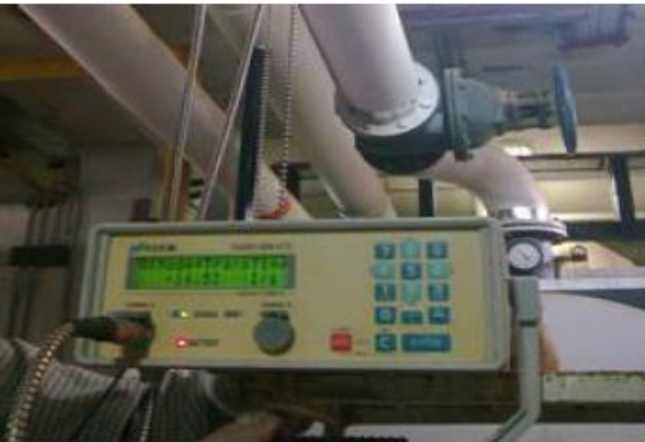
اندازه‌گیری دبی جریان آب گرم مصرفی ساختمانها
