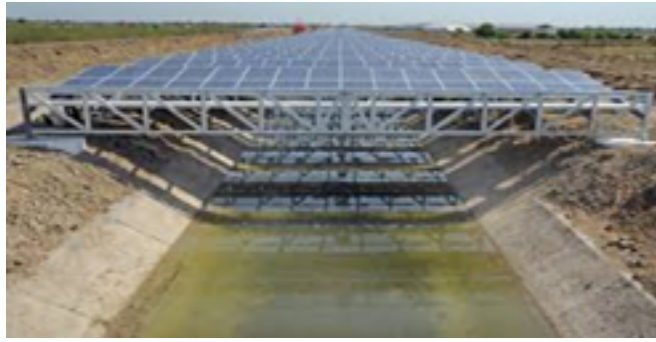
استفاده از پنل خورشیدی برای پوشاندن کانال
